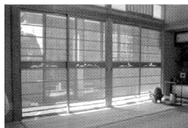
簾(すだれ)をはめこんだ建具 簾戸(すど)
