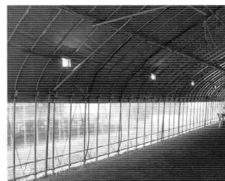
開閉式ビニールカーテン(横幕)とLED照明
