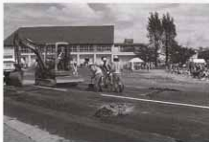
道路復旧作業
